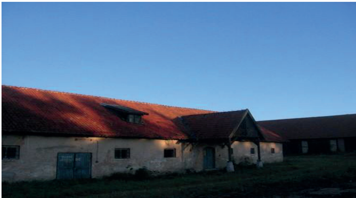
Magazyn paszowy – stan obecny.
